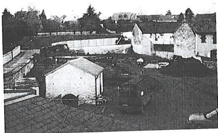
Novembre 2004 : les fouilles sont terminées, les semelles coulées aussitôt
