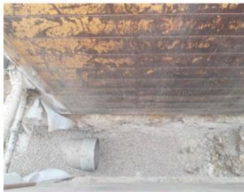
Pose réseau EP – Grande Rue (RD158) - JUM
