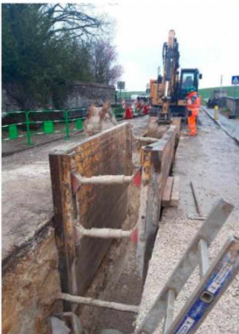
Pose réseau EP – Grande Rue (RD158) - JUM
