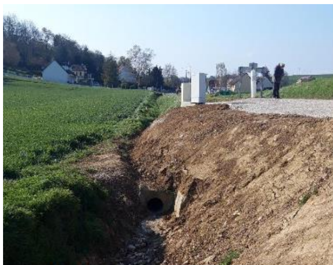
JUM – Aménagement fossé PR 1
